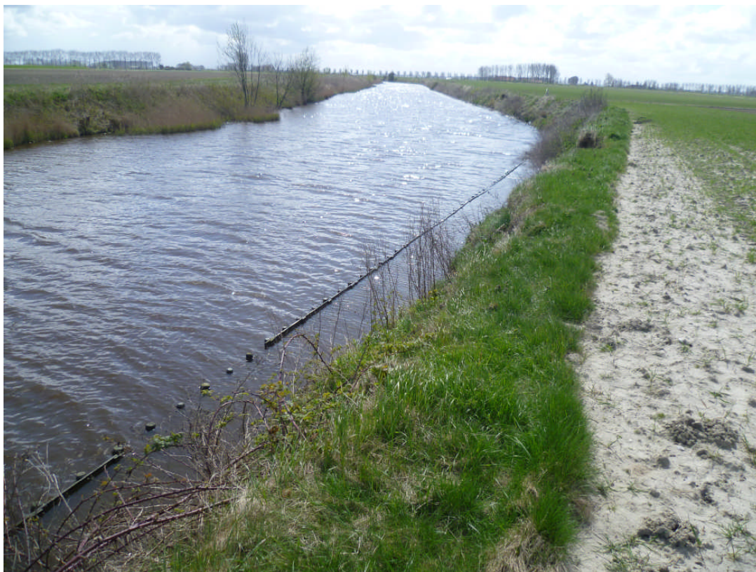
te verwijderen beschoeiing van palen en planken
