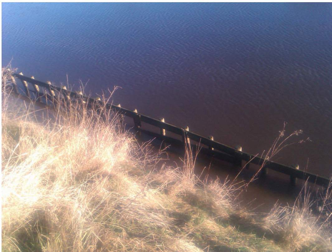
te verwijderen beschoeiing van palen en planken
